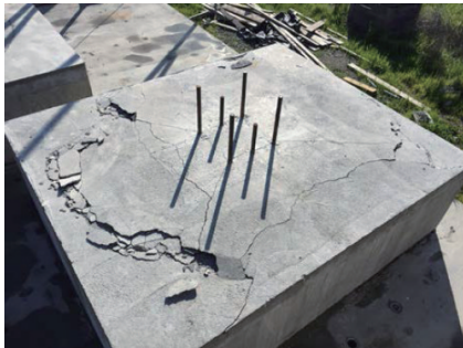
图 8 混凝土破坏
