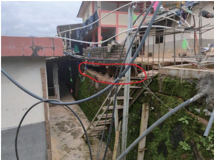
图 3 滑坡后缘土体沉降
