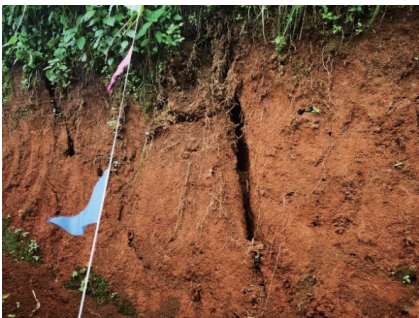
图 4 滑坡边界裂缝
