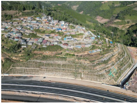
图 11 处置后边坡现状
