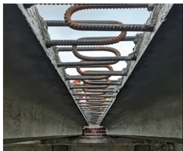
图 10 双 T 梁刚接缝示意图
