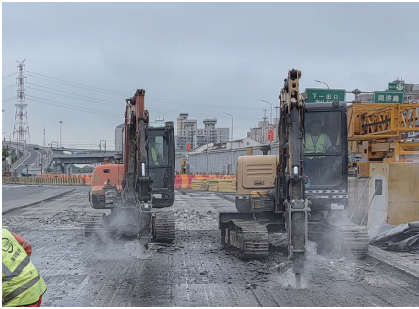
图 12 小型镐头机破除铰缝
