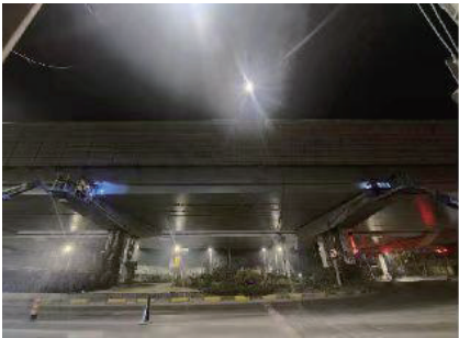
图3 老桥梁长测量
