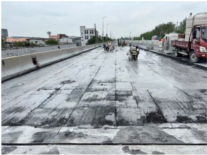
图 11 盘踞切割铰缝
