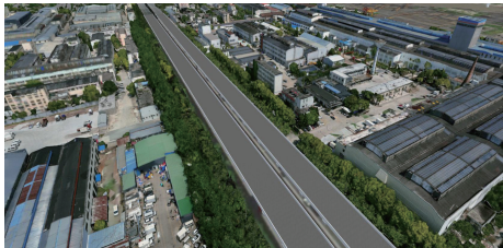
图15 泰和路高架桥倾斜摄影
