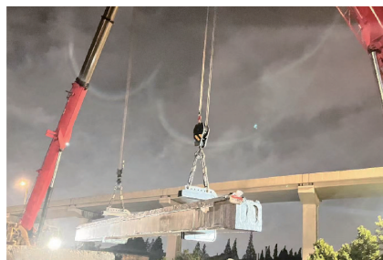
图 10 中梁 C 形吊架吊装
