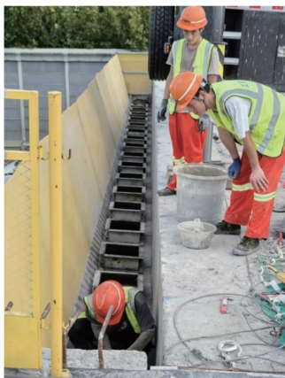
图4 早强 UHPC 垫石施工
