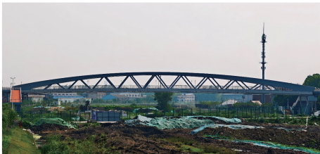
图1 主桥立面实景图
