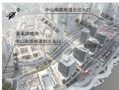
图8 中山南路地下道路建成后俯瞰
