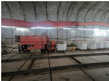
图 51 隧道内泵送黄泥照片 1
