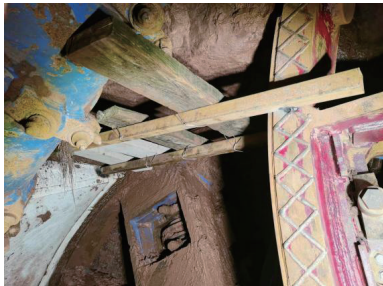
图43 开仓防护现场照片1
