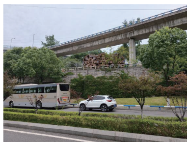
图25 顶管水平滑动至桥台侧面拆机区域
