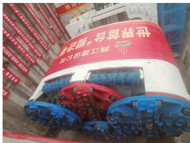
图12 “掘进号”矩形顶管机始发
