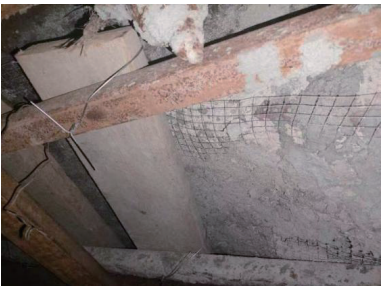
图44 开仓防护现场照片2
