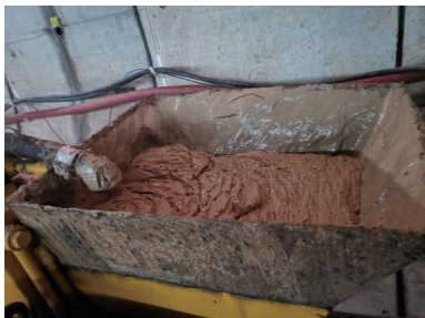
图 52 隧道内泵送黄泥照片 2
