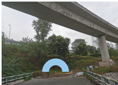
图10 隧道出口位置
