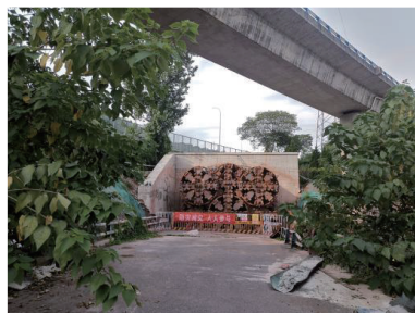
图23 顶管机在棚洞内贯通
