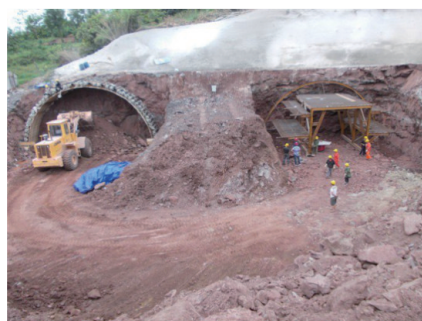
图2 金童路隧道现场施工照片
