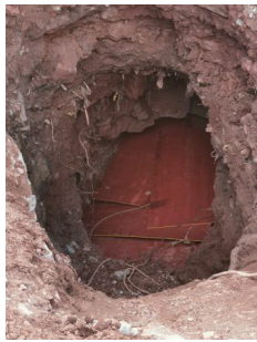
图 49 洞口采用砂浆回填
