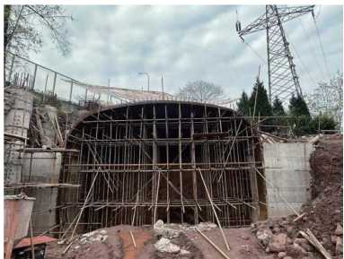
图19 出口棚洞结构现场照片
