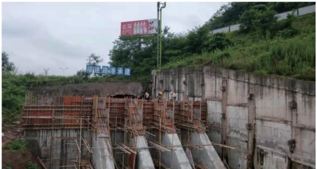
图 17 反力墙现场照片
