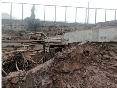
图18 内环高速路下施做管棚
