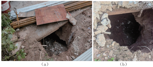
图 33 第 18 环顶进出现地面陷坑照片
