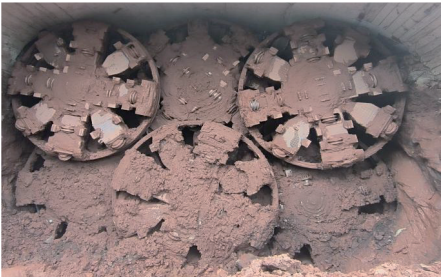
图 29 顶管贯通刀盘结饼照片(上部刀盘已冲洗)
