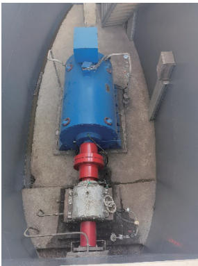
图2 不含齿轮箱的竖井贯流泵竖井内布置图
