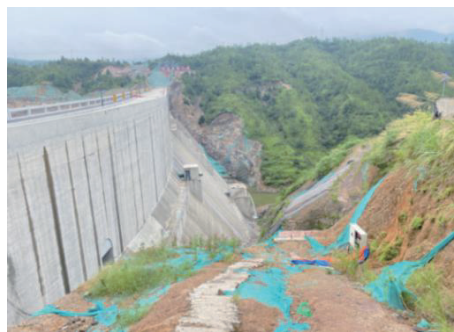
图 4 黄坑水库大坝图
