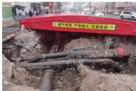
图5 南侧燃气和上水管线布置图
