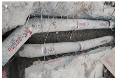
图4 北侧燃气管线布置图
