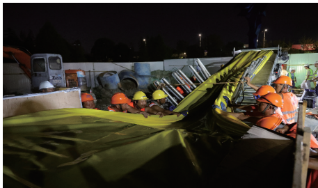
图 4 拉入 UV 内衬软管
