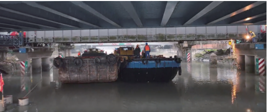
图8 浮船(等待钢板梁切割吊放)
