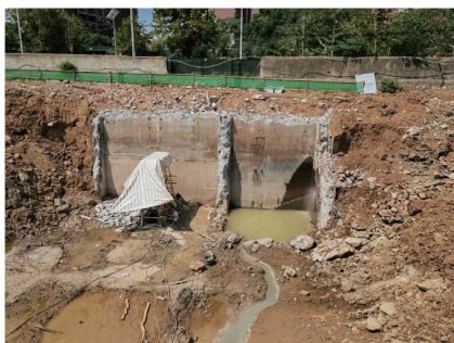
图2 既有泵房现状图
