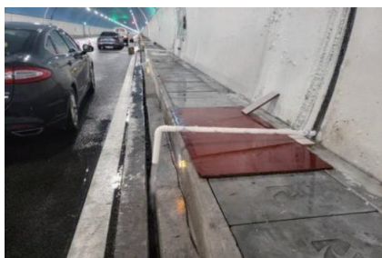
图7 隧道侧壁排水减压处理
