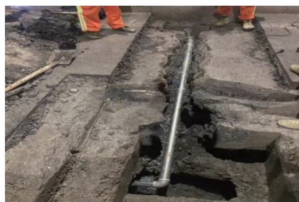
图9 DN65高压水管埋设
