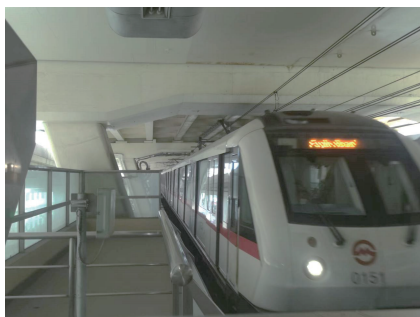
图7 上海1号线公轨共建段轨道层实拍图
