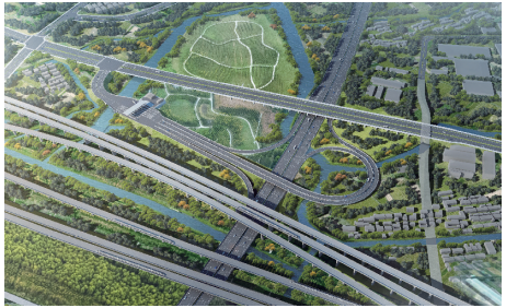
图10 金昌西路收费站整体风貌
