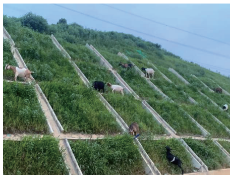
图4 致用路边坡采用锚杆框架+植生袋植草防护
