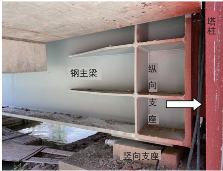
图4 塔梁分离体系实景
