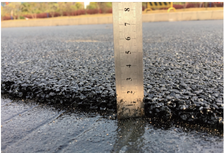
图1 超薄磨耗层加铺后照片
