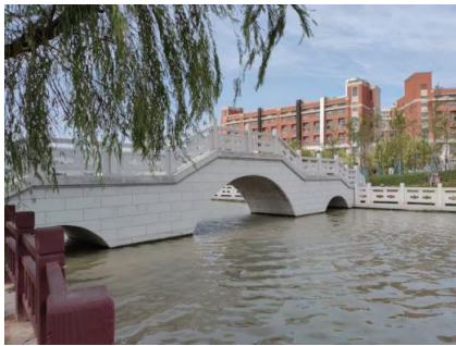
图10 花溪岛新建拱桥
