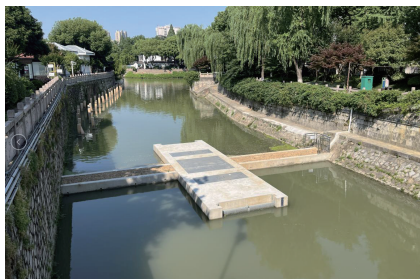
图8 堰泵合建实施完成现场照片
