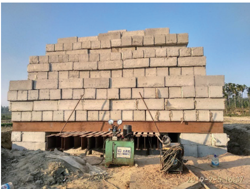
图1 桩基荷载试验加载(69号P11桥墩)
