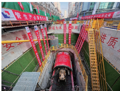
图4 管道施工过程照片
