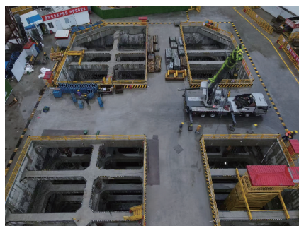
图7 深基坑施工过程照片
