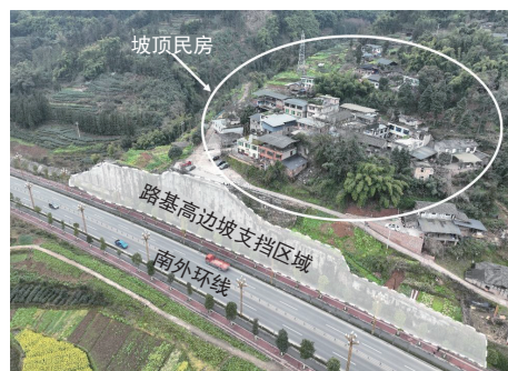
图1 工程实景照片
