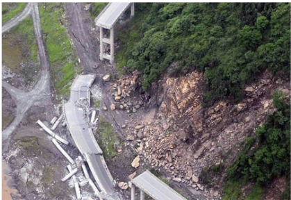
图2 汶川地震中破坏的百花大桥
