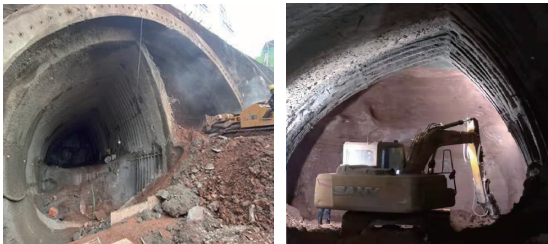
图 12 现场左下导坑开挖、左上导坑开挖照片
