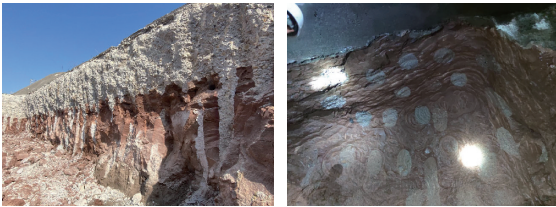
图8 现场粉砂岩高压旋喷加固后洞外/洞内照片
