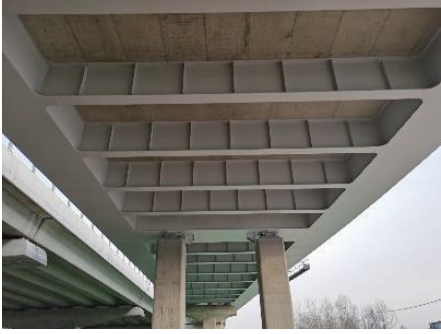
图8 匝道变宽段组合梁实景
