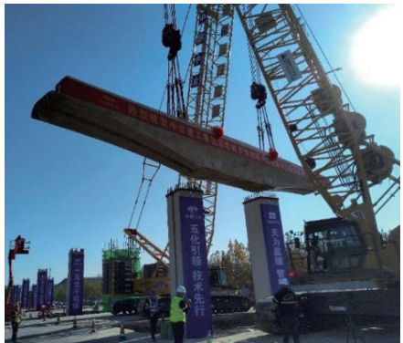
图9 主线预制盖梁吊装
