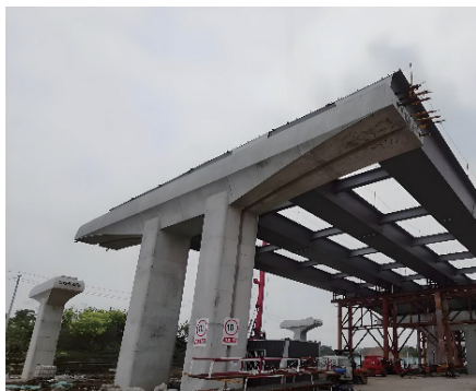
图10 立交下部结构实景图
