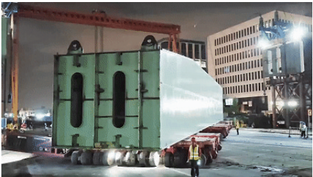
图6 SPMT短驳模块车组运输图
