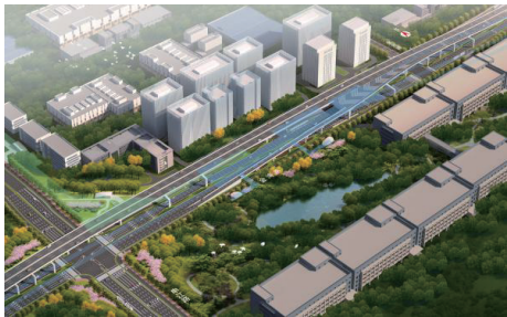
图 1 金海路改建工程 2 标工程概况图
