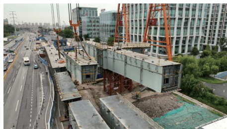
图9 双龙门吊悬臂拼装图
