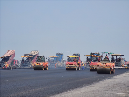
图3 摊铺施工现场
