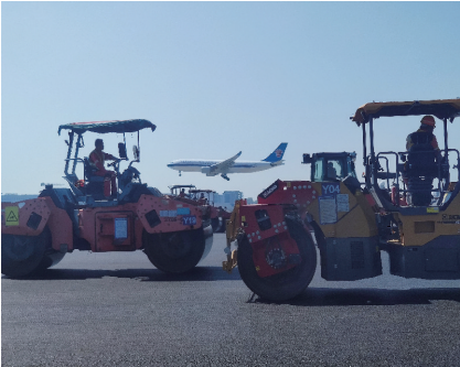
图4 碾压施工现场
