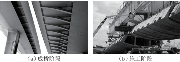
图1 马来西亚槟城双溪桥施工照
