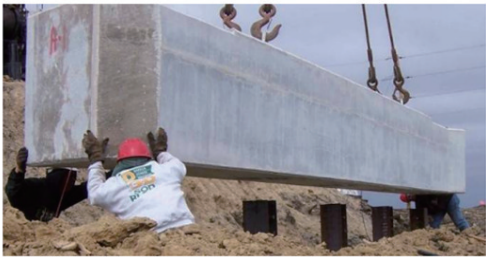
图 1 美国布恩县预制桥台
