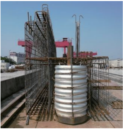
图 9 预制桥台钢筋
