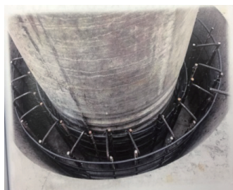
图4 承插式连接现场照片
