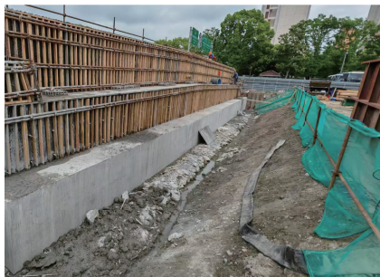
图2 承台侧壁待回填区域
