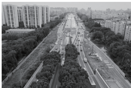
图1 某高速公路交通功能完善工程原状
