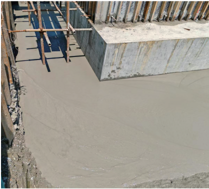
图4 流态回填材料浇筑回填承台侧壁效果
