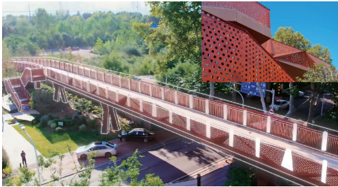
图5 建设一路桥建成实景
