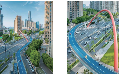
图3 和平大道桥建成实景
