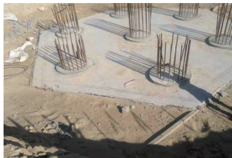
图5 桩头防水保护层施工效果示意图
