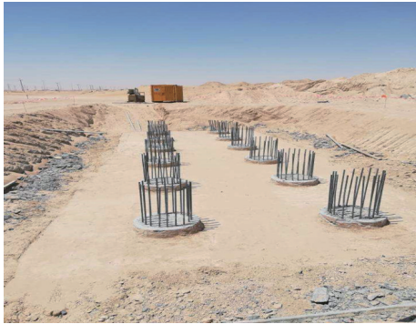
图 3 桩头清理施工效果示意图
