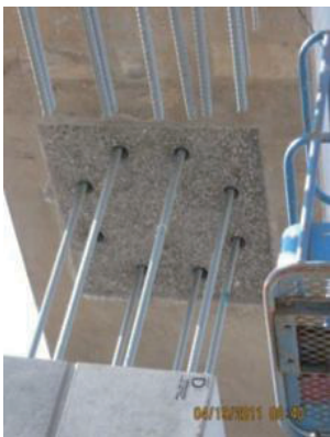
图8 灌浆套筒连接
