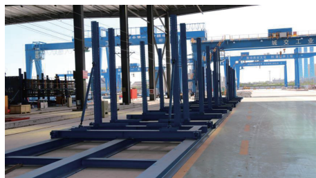
图14 立柱钢筋笼胎架
