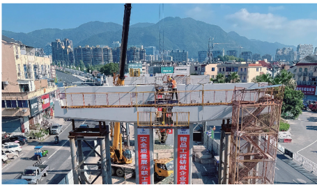
图 16 盖梁吊装就位与精调
