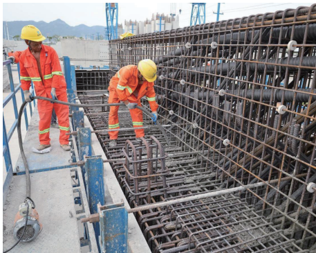
图 15 盖梁浇筑现场
