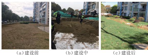
图2 雨水花园建设过程
