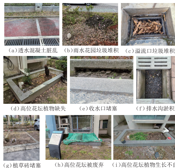
图12 损坏、被侵占及缺乏维护的海绵设施
