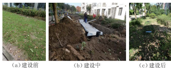
图5 地下装配式延时调节设施建设过程
