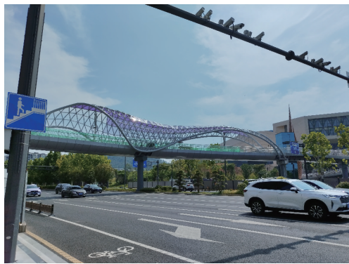
图7 青山路口人行天桥实景图
