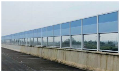
图5 成都天府机场高速全封闭声屏障
