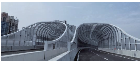
图 4 上海北横通道全封闭声屏障
