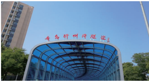
图 3 青岛胶州湾海底隧道全封闭声屏障
