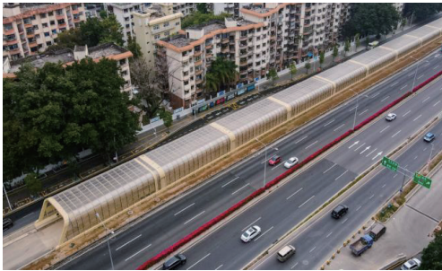
图 2 深圳东部过境通道全封闭声屏障
