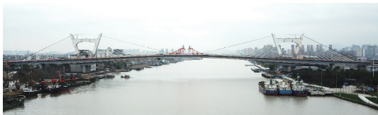
图9 主桥中跨合龙完成
