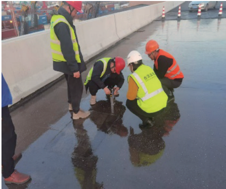
(b) 拉拔检测(与桥面板)
