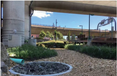
图 11 高架排水进入生物滞留带
