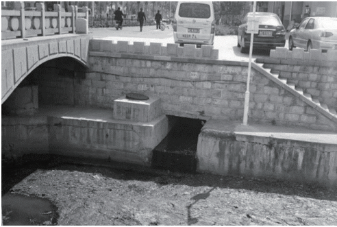
图4 污水方沟阻挡雨水管沟排河
