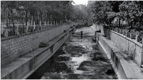
图3 污水方沟占用河道断面
