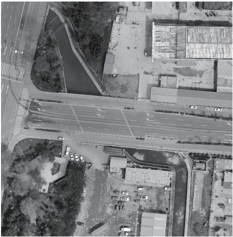
图2 涝淄河-政通路现状河道航拍图
