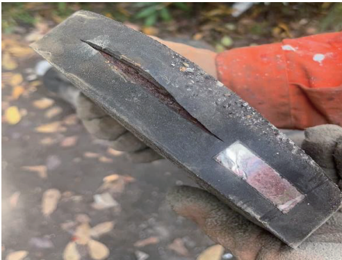
图 2 支座开裂与剪切变形典型照片
