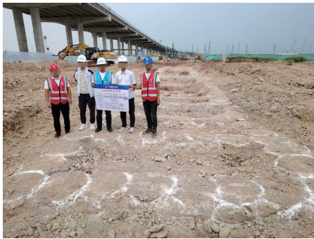
图9 三轴搅拌桩验收现场图
