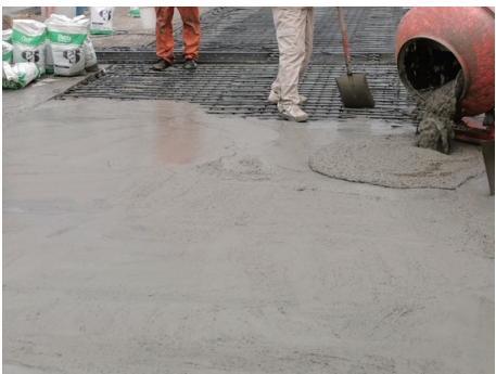
图7 高性能材料修复铰缝
