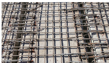
图 3 现场钢筋布置
