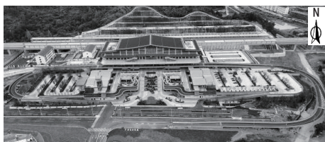
图1 楠溪江站站前交通枢纽实景照片
