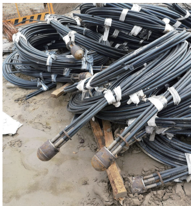
图5 预应力可回收锚索照片
