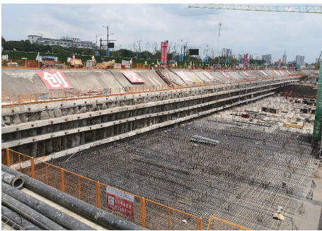
图7 基坑开挖照片
