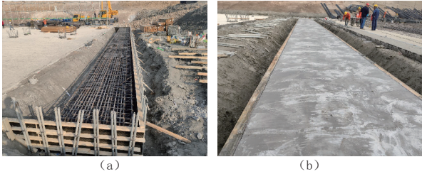
图6 枕梁现场施工照片
