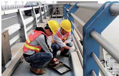
图 4 某跨江悬索桥接地电阻现场检测实景
