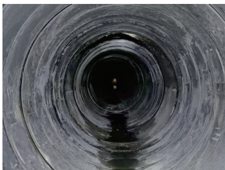
图8 不锈钢快速锁修复后情况
