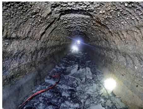
图7 管底硬质沉积情况
